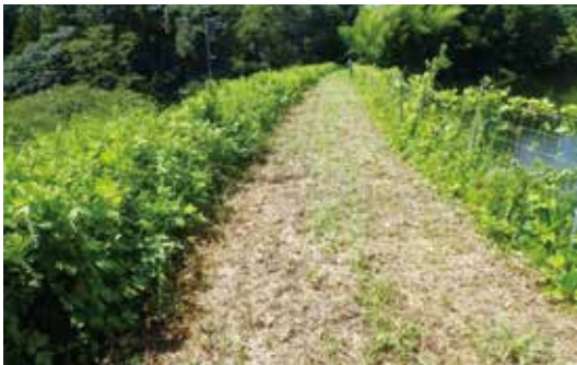
堤体天端だけ、草刈りがされているだけで法面の状況が確認できない
