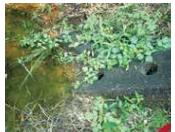
ため池栓を開けて低水位管理されている
