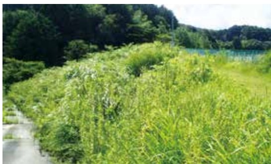
堤体下流法面に草が生い茂り、目視により異常を確認することができない
