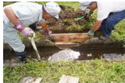
U字溝の改修作業
