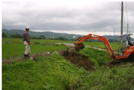
農用地法面の補修
