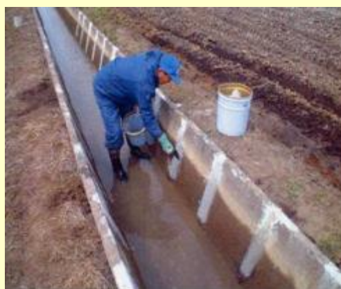
目地詰め作業
