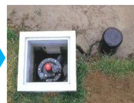
給水栓の自動化へ改良
