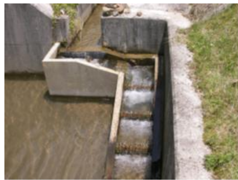
段差解消水路
