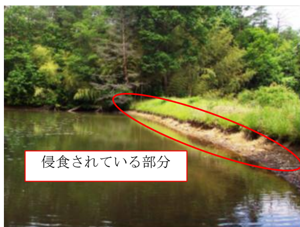
侵食が生じているため池堤体
