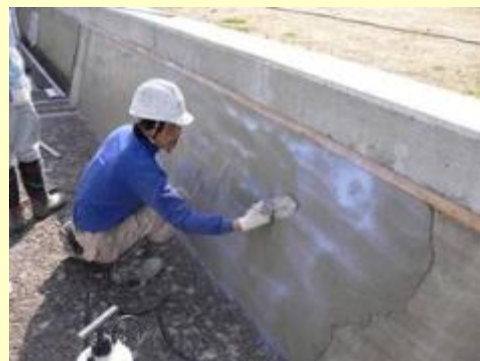
コーティング作業の状況
