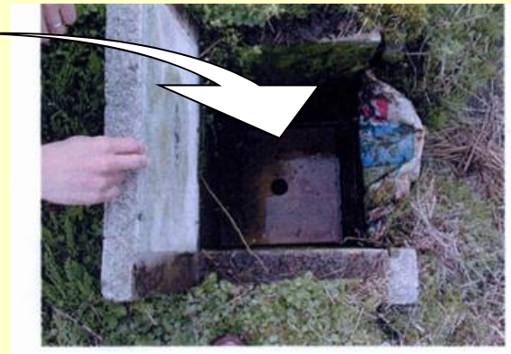
排水調整板設置状況
