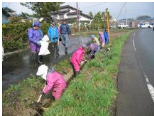
側溝の泥上げ
