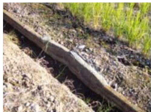
改修したU字溝
