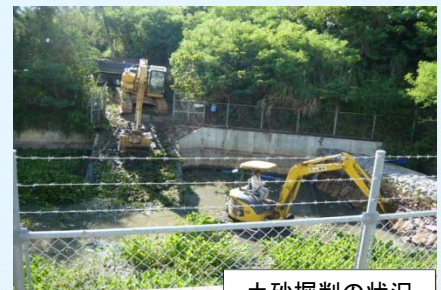
土砂掘削の状況
