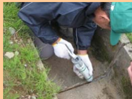
■ 水路の老朽化箇所の補修
