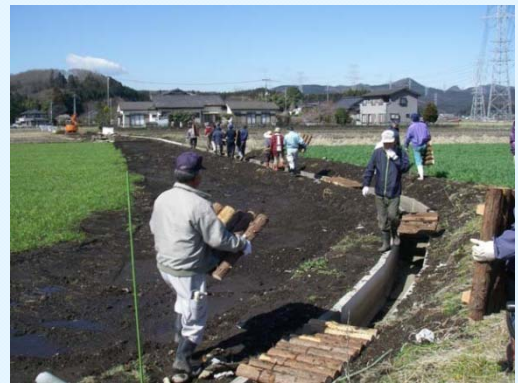
水路に木製蓋を設置
