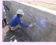
老朽化した水路のコーティング等による補修
