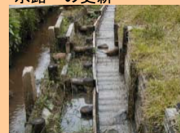
■ 水田魚道の設置
