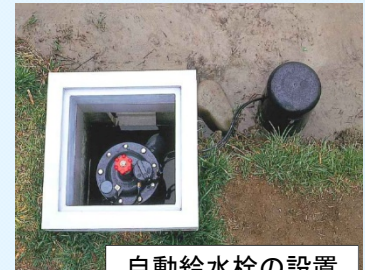
自動給水栓の設置
