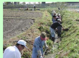
■ 水路の保全管理
