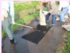
農道舗装の補修
