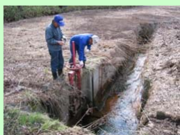
■ 点検・機能診断
