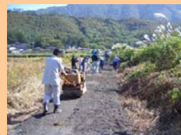
■ 農道舗装の補修
