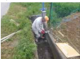
水路の軽微な補修
