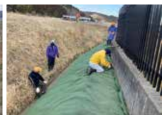
防草シート設置
