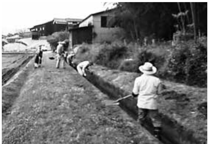
区・環境整備 水路の泥上げ・整備
