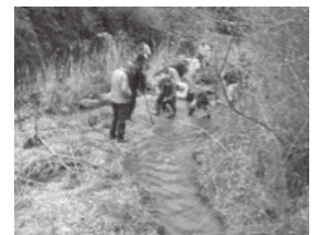
取水口の泥上げ 音羽支部
