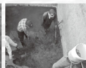
調圧水槽の泥上げ 榑支部
