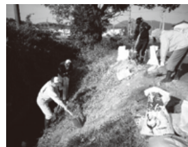
排水路法面修復作業 神森支部
