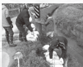
異常気象後の応急処置 杉谷支部
