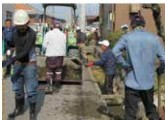
写真5 水路底のコンクリート化
