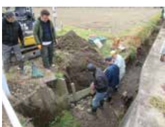
写真2 倒壊水路壁の補修
