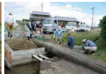
写真6 水路壁の嵩上げ
