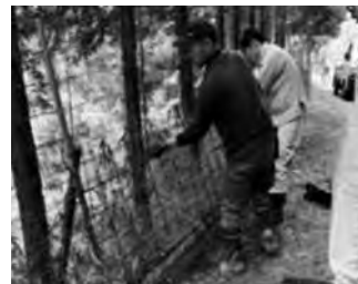
柵の設置作業
