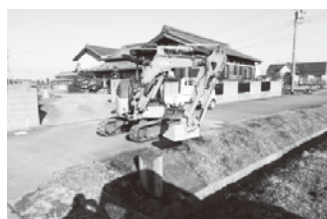
水路法面整地
