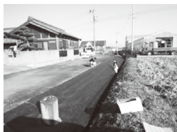
水路法面防草シート張り
