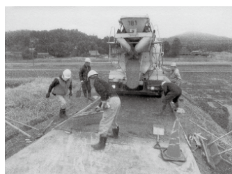
コンクリート打設状況
