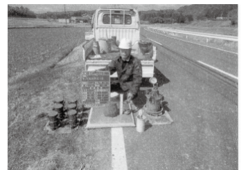
コンクリート試料の採集状況
