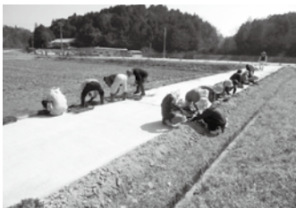
農道のコンクリート舗装及び植栽
