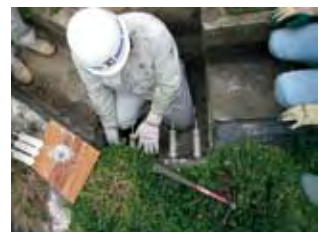
IPHシステム (内圧充填接合補修工法)
