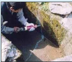
ひび割れの補修
