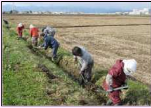
水路の泥上げ
