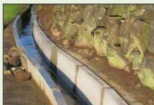
素堀り水路からの更新
