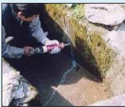
ひび割れの補修
