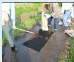
農道の部分補修
