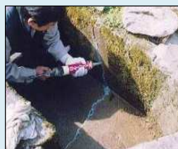
ひび割れの補修
