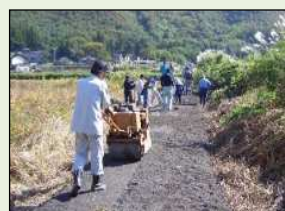
未舗装農道の舗装
