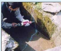
ひび割れの補修
