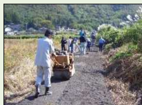
未舗装農道の舗装
