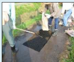
農道の部分補修
