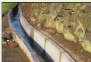
素堀り水路からの更新
