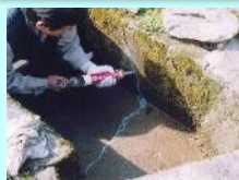
水路のひび割れ補修
