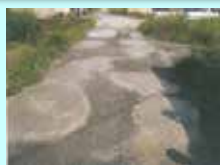
農道の窪みの補修
