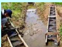
水田魚道の設置
