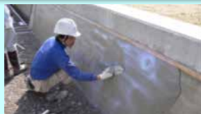
老朽化した水路壁のコーティング
