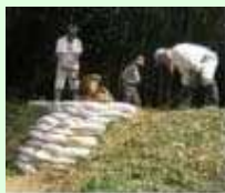
漏水箇所の補修
