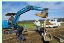
コンクリート水路の更新
