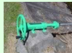
ゲート、バルブの更新
