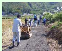
未舗装農道の舗装
