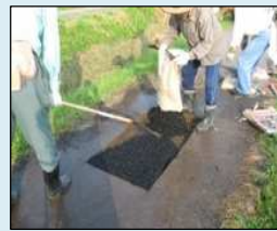
農道の部分補修
