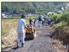
未舗装農道の舗装
