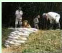
漏水箇所の補修
