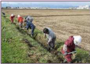
水路の泥上げ
