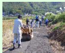
未舗装農道の舗装
