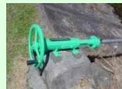
ゲート、バルブの更新
