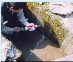
ひび割れの補修
