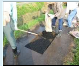
農道の部分補修
