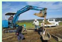
コンクリート水路の更新
