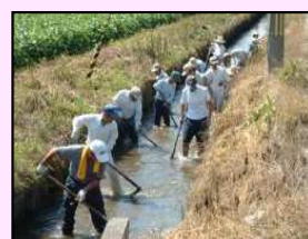
水路の泥上げ
