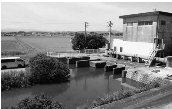
東黒部排水機場（施工前）
