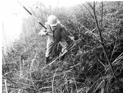
緊急点検の様子 (津市内)
