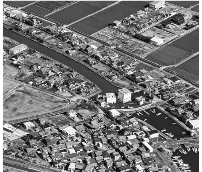
排水機場の整備 (桑名市)
