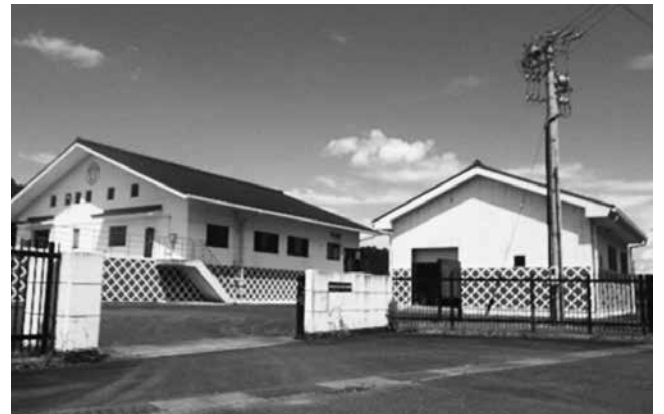
集落排水施設の整備 (伊賀市)
