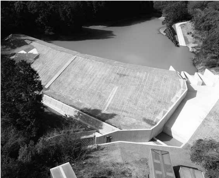
農業用ため池整備 (御浜町)
