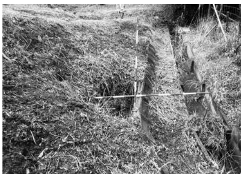
緊急点検の様子 (津市内)
