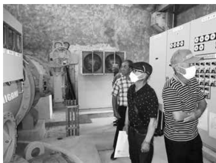
機場内で操作盤等を見入る参加者
