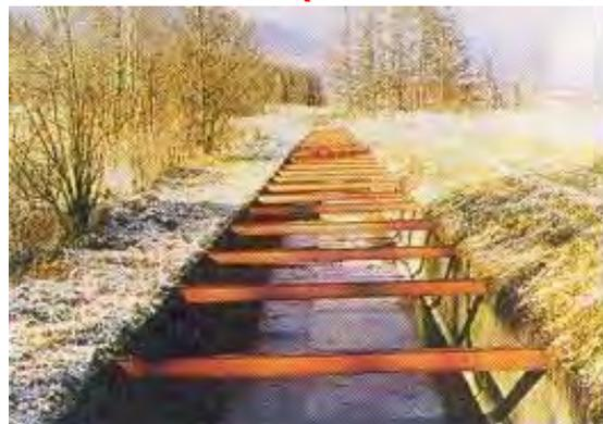
支点の不同沈下によるひび割れ(支持力不足) 開水路側壁(凍上圧の補強対策)
