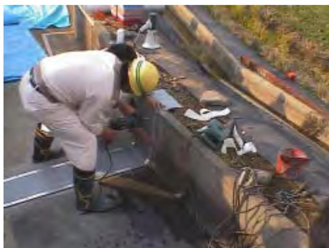
シートの両側をアルミフレーム(アンカー止め)で固定し完成
