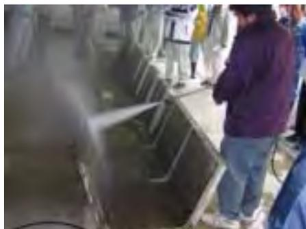
高圧水で壁面を洗浄し、ゴミやコンクリートの弱い部分を落とす
