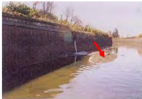
開水路底版(浮力による損傷)
