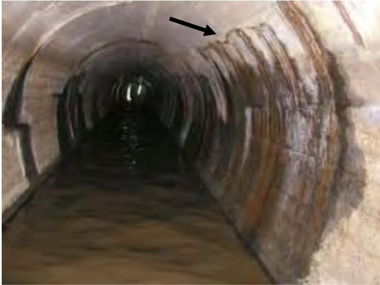
トンネル肩口の位置で軸方向に伸びているひび割れは**要注意**
