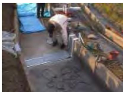
目地にシートをかぶせる。その際に、ブチルゴムシールにより構造物に接着させる
