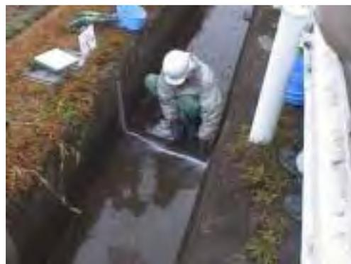
ひび割れ部をU字カットした後、手でパテを充てんすれば完成
