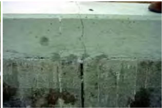
目地衝突による躯体の破損
