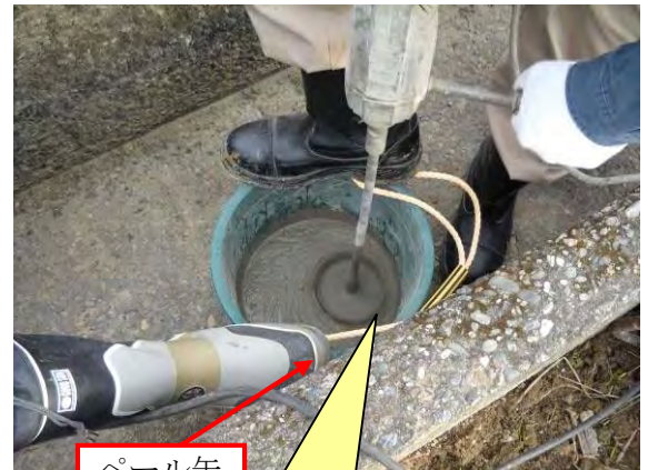
練り混ぜ状況
