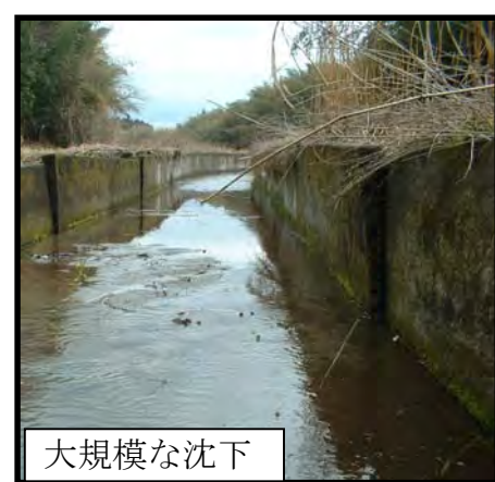
図 3-1 簡易補修には適さない変状例
