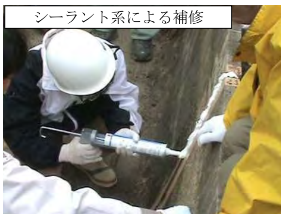
図 5-1 補修材料別施工例
