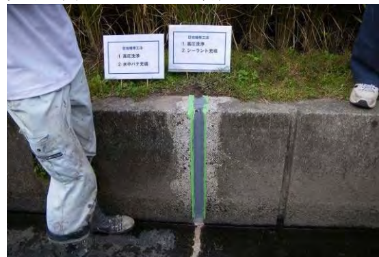
完了（弾性シーリング材）
