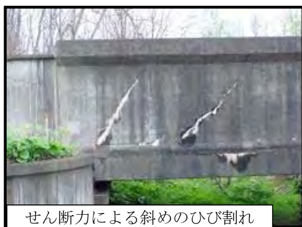
図 3-1 簡易補修には適さない変状例
