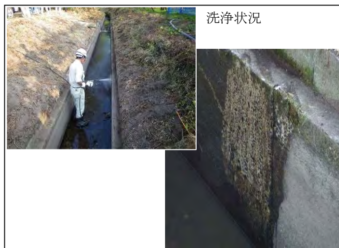
図 6.1-1 動力噴霧機など下地処理の一例
