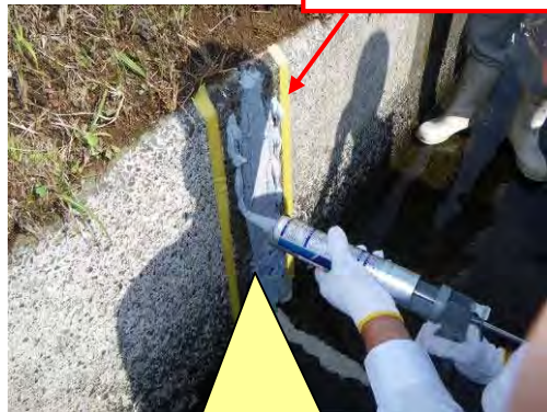
塗布・充てん状況
