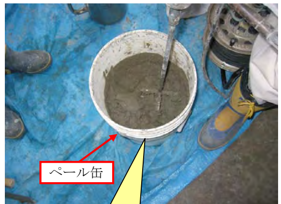
練り混ぜ状況
