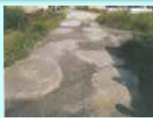
農道の窪みの補修
