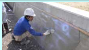
老朽化した水路壁のコーティング
