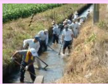
水路の泥上げ
