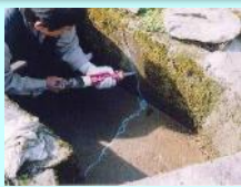
水路のひび割れ補修
