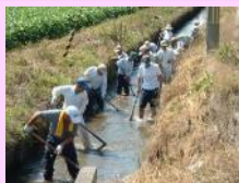
水路の泥上げ
