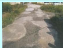
農道の窪みの補修
