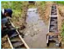
水田魚道の設置
