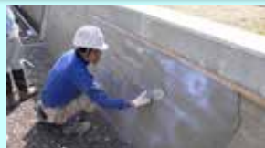
老朽化した水路壁のコーティング
