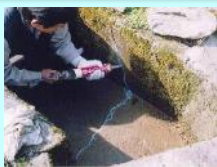
水路のひび割れ補修
