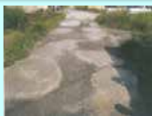
農道の窪みの補修
