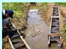
水田魚道の設置
