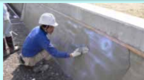
老朽化した水路壁のコーティング
