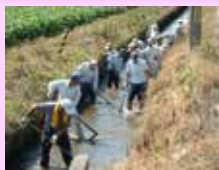
水路の泥上げ
