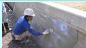
老朽化した水路壁のコーティング
