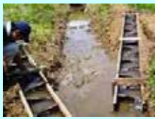
水田魚道の設置
