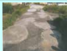
農道の窪みの補修
