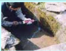
水路のひび割れ補修
