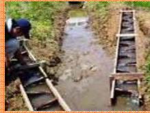
水田魚道の設置
