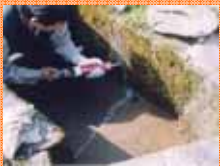
水路のひび割れ補修
