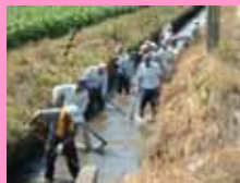
水路の泥上げ
