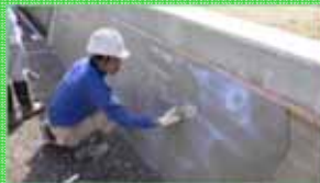
老朽化した水路壁のコーティング
