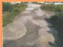
農道の窪みの補修
