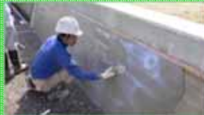
老朽化した水路壁のコーティング
