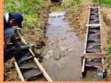
水田魚道の設置
