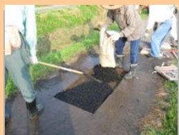
■ 農道舗装の補修
