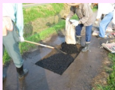
農道舗装の補修
