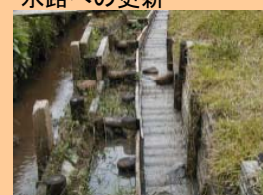
■ 水田魚道の設置
