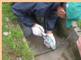
■ 水路の老朽化箇所の補修
