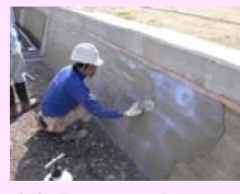
老朽化した水路のコーティング等による補修
