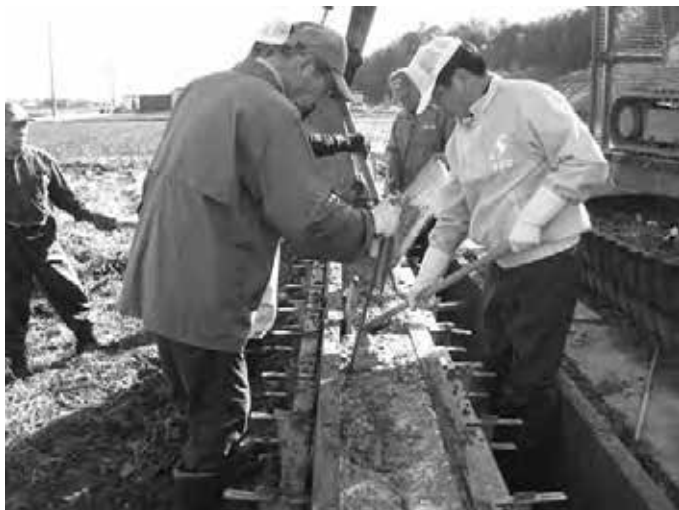
水路の自主施工による補修
