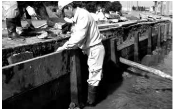
用水路の改修工事を地域が力合わせて
