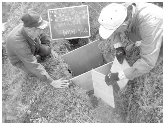
型枠から自分たちで補修
