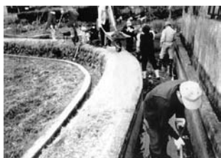
水路の清掃作業
