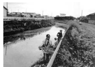
幹線排水路の草刈り
