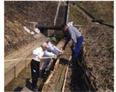
【しがらみ（柵作成工法）】
