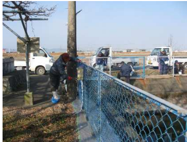
フェンスの防錆塗装
