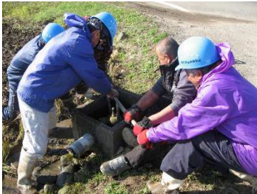
破損施設の補修
