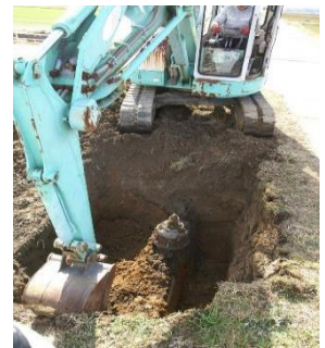
パイプライン仕切弁掘削調査・交換
