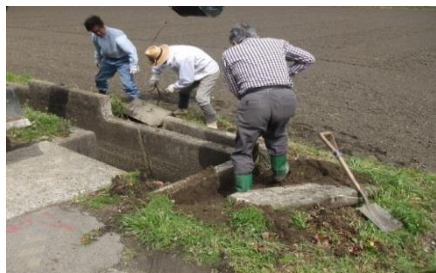
パイプライン仕切弁掘削調査・交換
