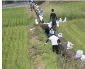
水路の泥上げ
