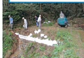
復旧作業状況
