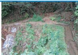
台風15号による災害状況
