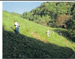
堤の草刈り作業状況
