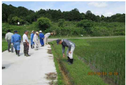
農業用施設の点検
