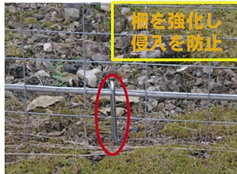
獣害柵の補修状況
