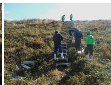
ため池堤体への階段設置
