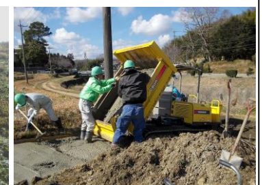
農道取付部のコンクリート舗装
