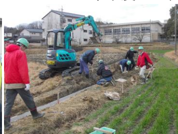
フリューム敷設
