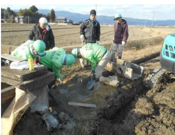
フリュームの敷設替え
