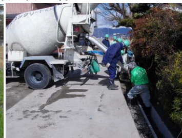
水路犬走りの張コンクリート
