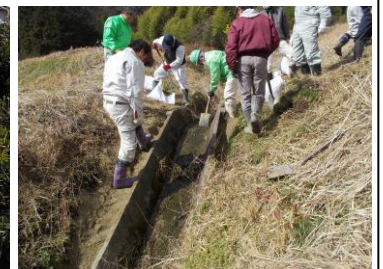
V字溝周辺の沈下補修
