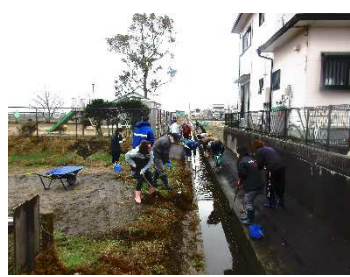
排水路清掃作業
