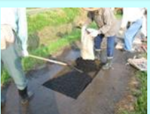
農道の部分補修
