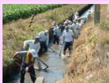
水路の泥上げ
