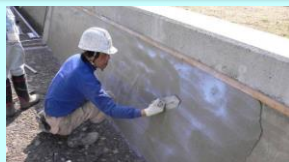
老朽化した水路壁のコーティング
