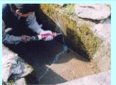
水路のひび割れ補修
