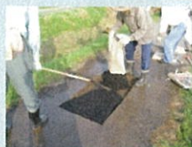
農道の部分補修
