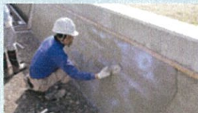
老朽化した水路壁のコーティング
