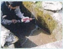
水路のひび割れ補修
