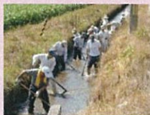
水路の泥上げ
