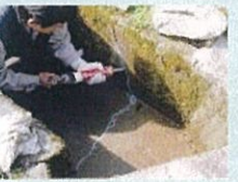
水路のひび割れ補修
