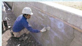
老朽化した水路壁のコーティング
