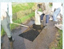
農道の部分補修
