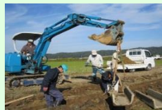
コンクリート水路の更新
