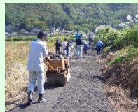
未舗装農道の舗装
