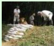
漏水箇所の補修
