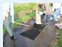
農道の部分補修
