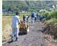
未舗装農道の舗装
