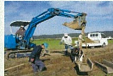
コンクリート水路の更新
