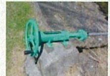
ゲート、バルブの更新
