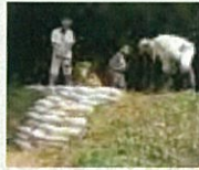
漏水箇所の補修
